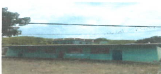
Foto 1: CUBIERTA DE LAMINA
