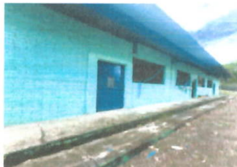
Foto 4: PINTURA EN MUROS INTERIOR Y EXTERIOR
