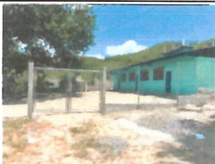
Foto 3: Mantenimiento a portón
